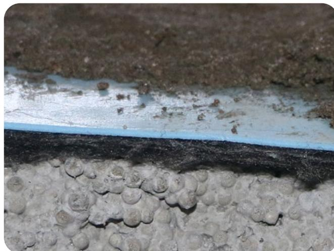
Sur chantier, l'incidence acoustique réelle de la préchape sera très différente d'une mise en œuvre à l'autre (présence de gaines techniques, densité de la préchape, épaisseur appliquée, type de mélange utilisé, etc.). In situ, l'amélioration éventuellement apportée par une préchape n'est donc jamais assurée.
